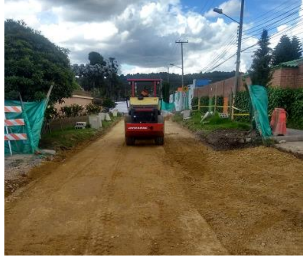
Fuente: Oficina Infraestructura F.D.L. SUBA Escarificación material remanente y compactado de material granular
