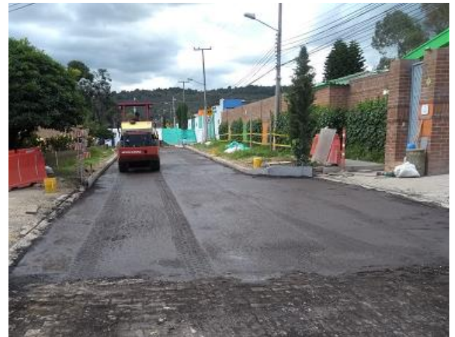
Fuente: Oficina Infraestructura F.D.L. SUBA Extendida y compactado fresado estabilizado
