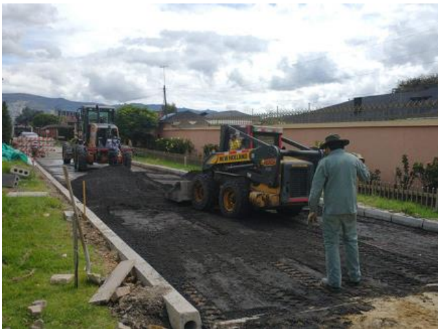
Fuente: Oficina Infraestructura F.D.L. SUBA Extendida y compactado fresado estabilizado
