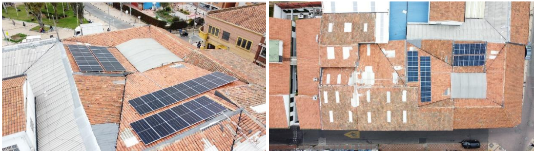
Imagen 3. Instalación de sistema fotovoltaico – Sede casa de la Participación ALS.
