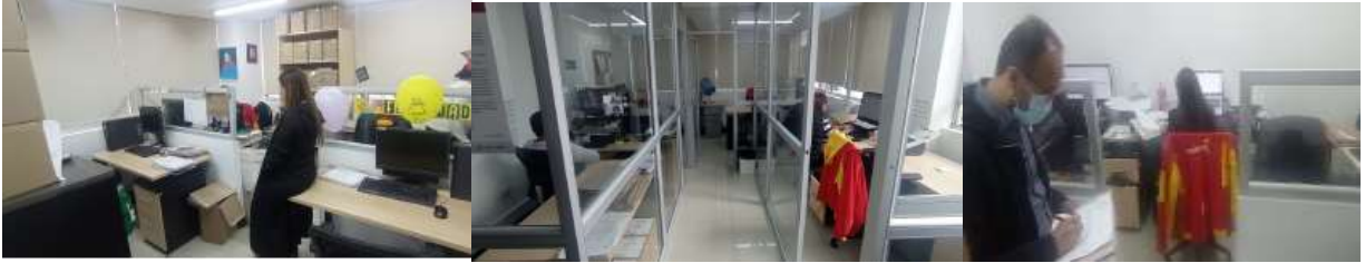
Imagen 3. Inspecciones luminarias y equipos electrónicos.
