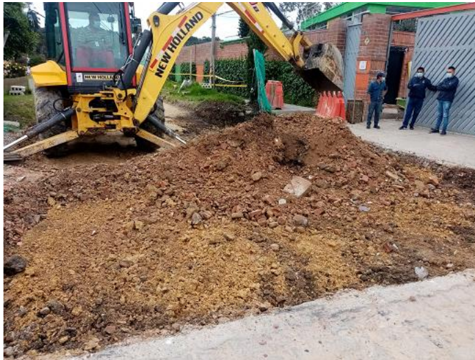
Fuente: Oficina Infraestructura F.D.L. SUBA Escarificación material remanente y compactado de material granular
